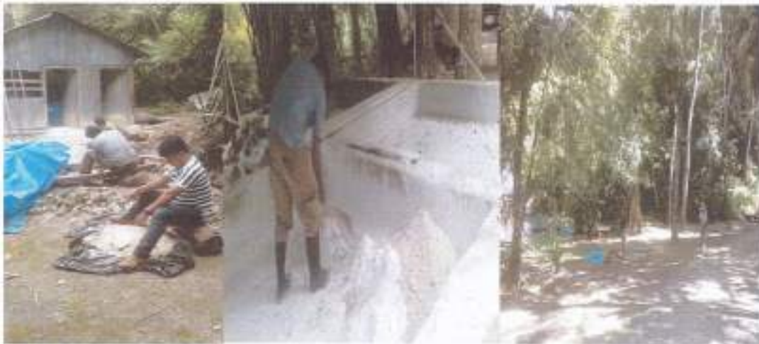
Triturado de pedrín para pisos, barrido del área de bodega, elaboración de mezcla para pisos
