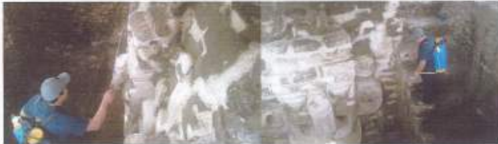
Limpeza mecánica en Húmedo del mascarón chac Oeste en estructura 5D-33-3ra.
