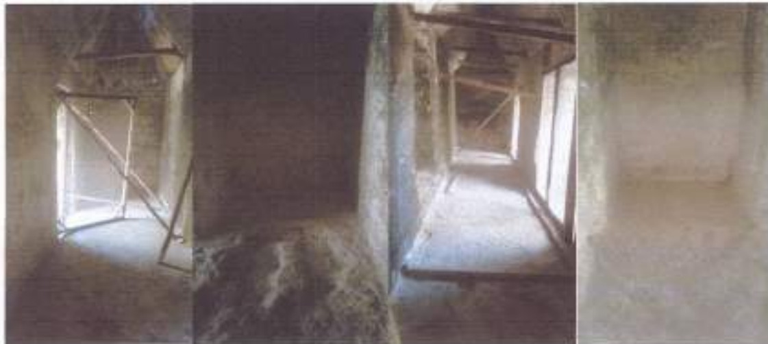
Limpieza mecánica en seco de cámara en templo VI
