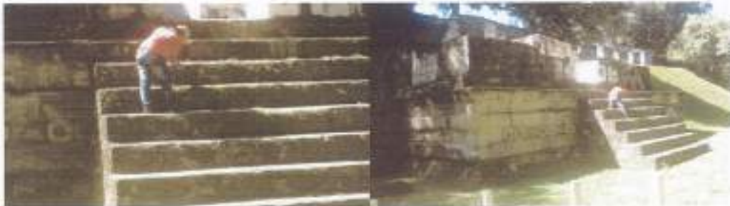
Desyerbe, chapeo, Barrido y limpieza en seco de estructura.
