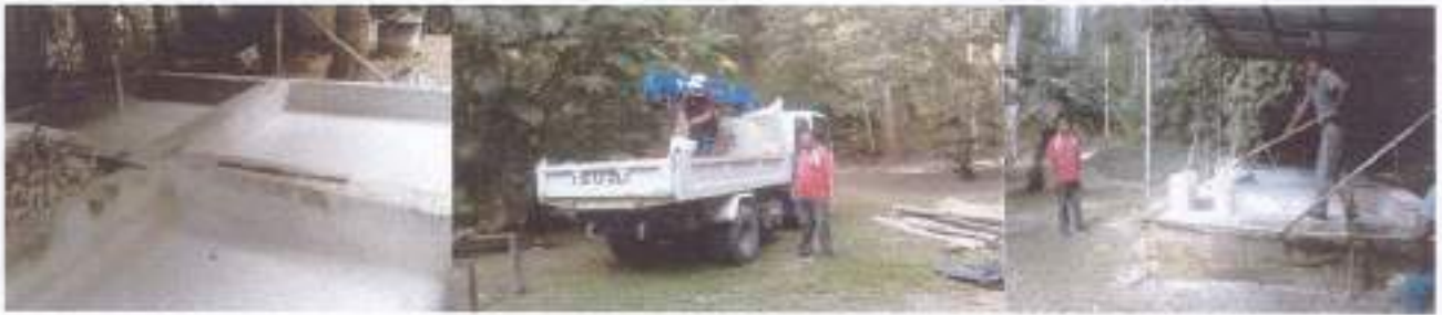
Fraguado cal en dos pileta traslado de mezcla para trabajos en túnel del chac este en estructura 5D-33
