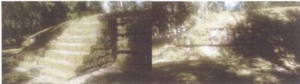
Limpieza mecánica en seco, chapeo, barrido y desyerbe a estructura.
