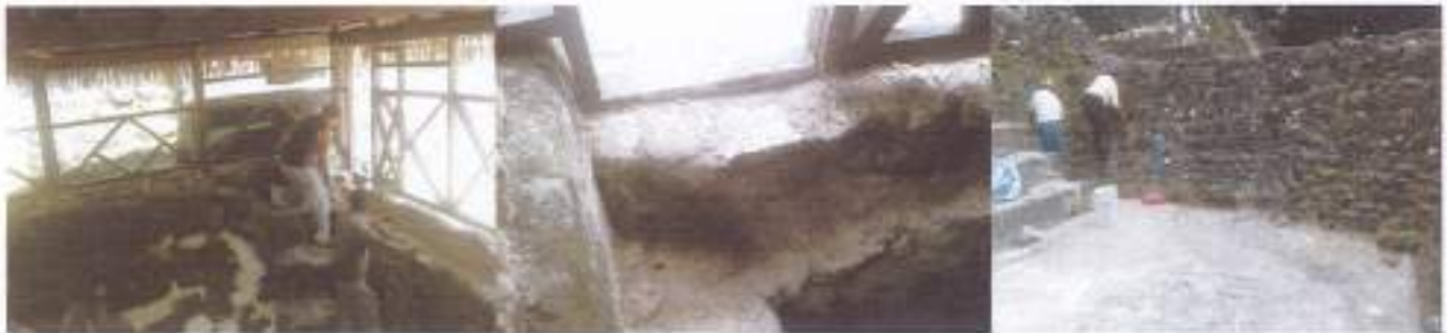
Conservación del pretil en cubierta como la limpieza del área este para su impermeabilización
