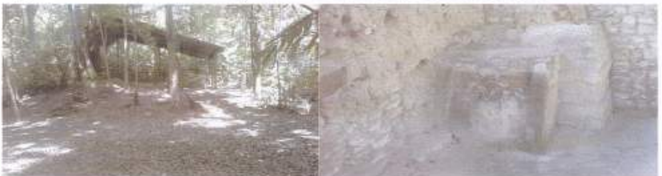
Limpieza mecánica en seco, barrido al área del monumento y estructura
