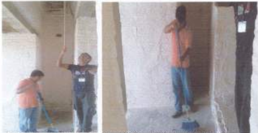
Podemos observar la limpieza mecánica en seco de la cámara
